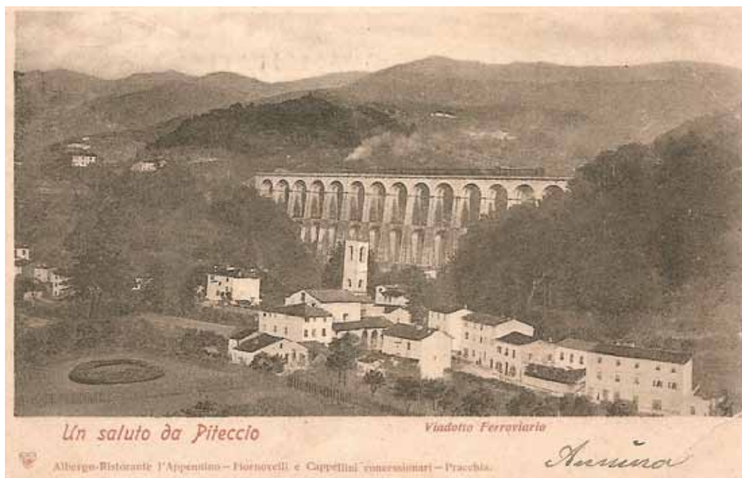
Piteccio - Viadotto Ferroviario (cartolina, 1901, coll. P. Bresci)
