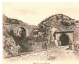
San Mommè - Viadotto d'Ombro (cartolina, 1906, coll. P. Bresci)
