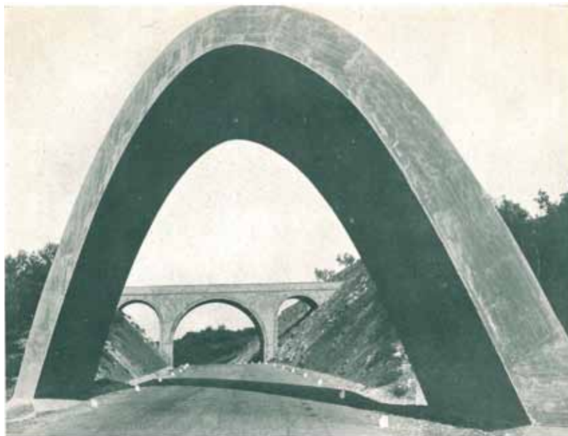
Sull'Autostrada Firenze-Montecatini-Viareggio - Fra le grandi opere di Serravalle: protezione di una teleferica (Ed. Bepi)
